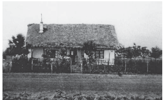
Unser so genanntes „großes Haus“ mit zwei Zimmern und der Küche war mit Stroh gedeckt. Nach zwei Jahren bot dieses Strohdach kaum noch Schutz bei heftigerem Regen. Wir mussten alle Eimer, Waschschüsseln und Gefäße auf dem Dachboden unterstellen, um das durchsickernde Regenwasser aufzufangen, damit die Zimmerdecke nicht durchweichte und herunterfiel. So sah unser Haus 1953 aus, ein Jahr bevor wir es umbauten.
