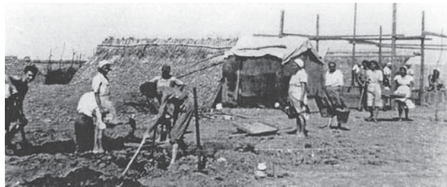
Häuserstampfen in Gemeinschaftsarbeit. Zwischen zwei Hütten wird ein Haus im Stampfverfahren gebaut. Links wird Lehm ausgegraben, Frauen tragen diesen zur Baustelle, wo zwischen dem Gerüst und Brettern die Hauswände gestampft werden.
