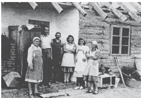
Nach viel und schwerer Arbeit in der Hitze der Bărăgan-Steppe steht endlich der aus Lehm gestampfte Rohbau mit dem daraufgezimmernten Dachstuhl.
